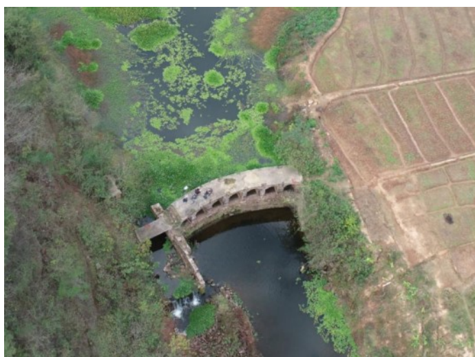
图 3-3 水闸现状照片
