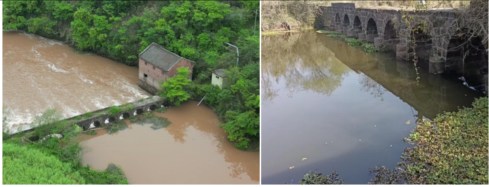
图 3-3 水闸现状照片
