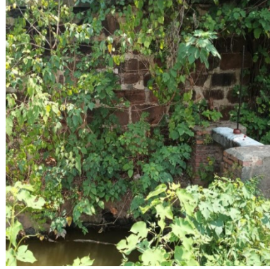
双口水闸灌溉渠进水闸现状
