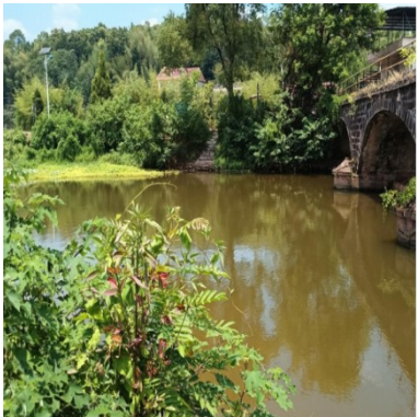
双口水闸闸墩上游现状
