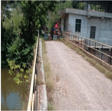
双口水闸交通桥现状
