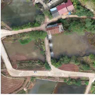
双口水闸现状
