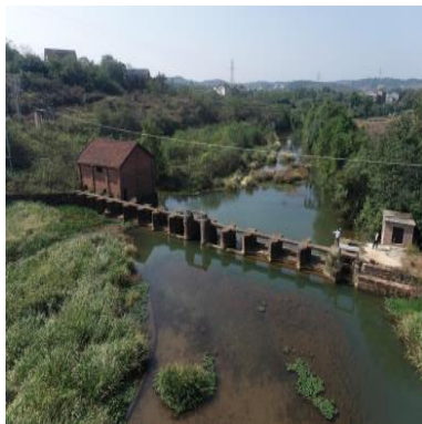
拦水巷水闸现状
