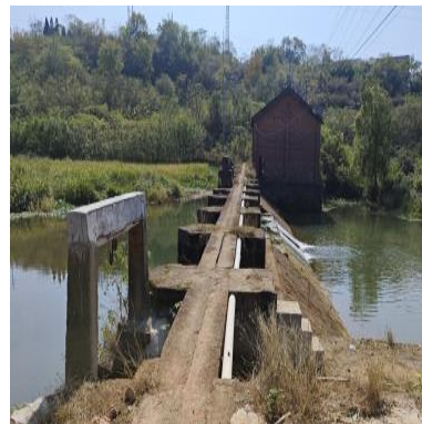
拦水巷人行交通桥及水轮泵房
